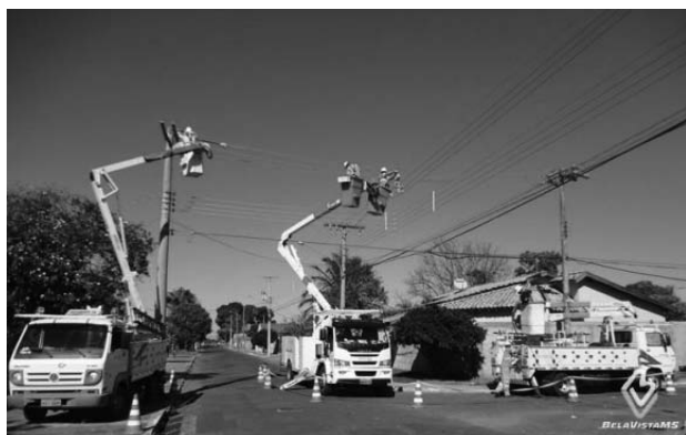
Eletricitas trabalhando em caminhões equipados com cesta aérea (Internet)
