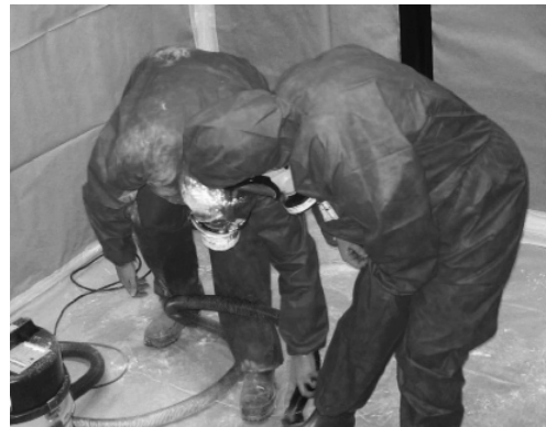
Figura 2 - Limpeza dos EPI com aspirador de partículas de alta eficiência (Martins, 2011)
