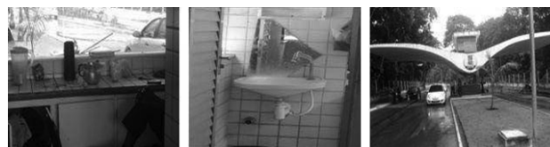
Figura 3 - Inadequações encontradas na guarita C
