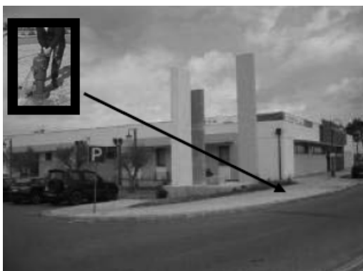
i) Ausência de hidrantes
