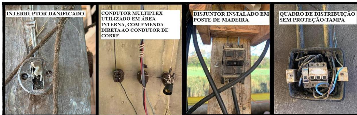
Figura 2. Instalações elétricas verificadas durante a pesquisa (Próprio autor, 2024).
