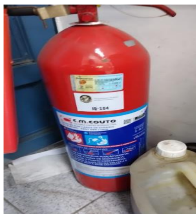
Figuras 3 e 4. Extintores obstruídos e no chão sem base de apoio (Autores, 2022).
