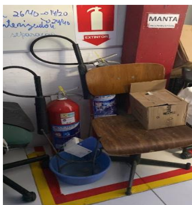
Figuras 3 e 4. Extintores obstruídos e no chão sem base de apoio (Autores, 2022).
