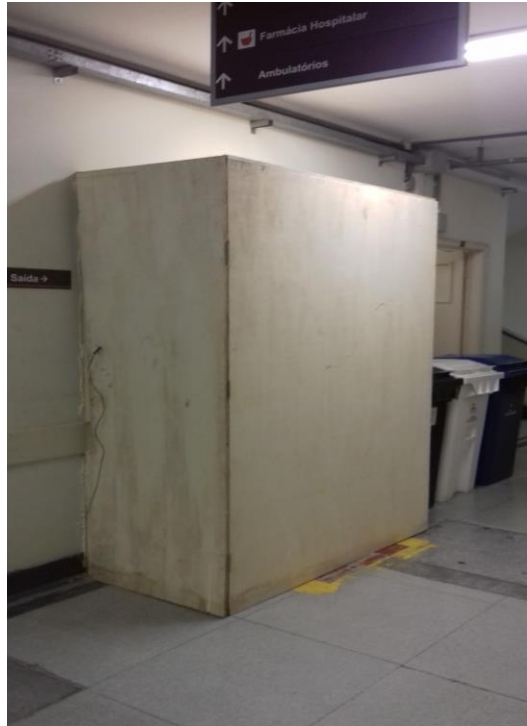
Figura 1 – Modelo de tapume para isolamento de área (Foto de Prado, 2019)
