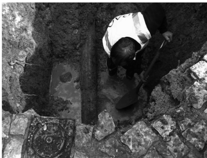
Figura 2 - Movimentação de terras no interior da vala saturada em água.
