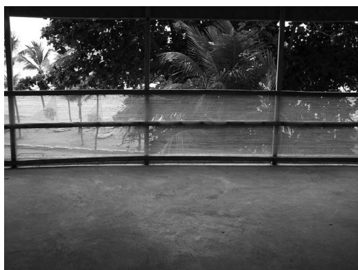
Figura 1 – Sistema de guarda-corpo e rodapé
