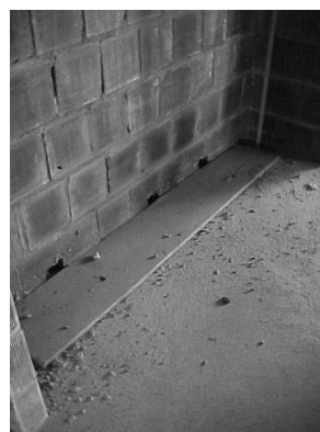
Figura 2 – Fechamento provisório do piso
