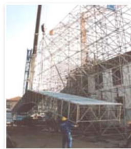
Fig.2 - Elevação de módulo de cobertura
