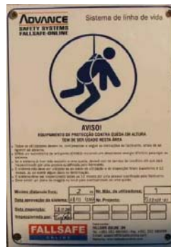
Fig.5: Sinalização de obrigação de utilização do referido equipamento a partir do local onde o trabalhador inicia a descida.
