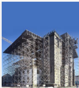
Fig.1 - Vista global da obra
