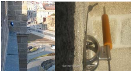
Fig.3: Linha de vida definitiva instalada de modo ao trabalhador encarregue na manutenção/reparação poder fixar o amês de segurança desde o momento em que inicia a descida pelos degraus até ao ponto mais desfavorável da cobertura inferior;
