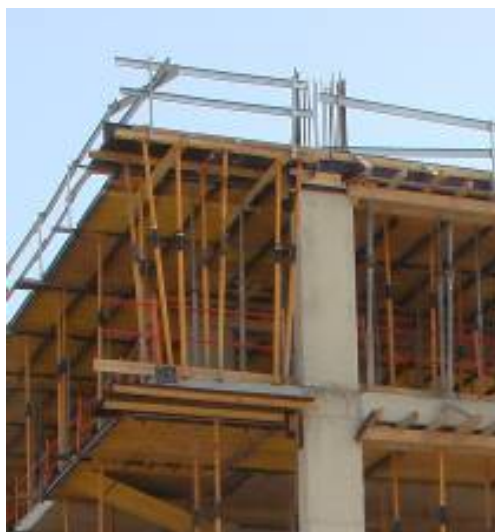
Figura 4 – Pormenores da construção corrente de vigas de bordadura x protecção contra quedas em altura
