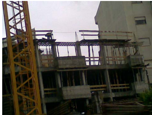
Figura 1 – Pormenor da construção corrente de vigas de bordadura
