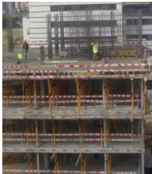
Figura 6 – Pormenor da colocação da protecção colectiva contra quedas em altura e evidência da sua compatibilização com as restantes operações
