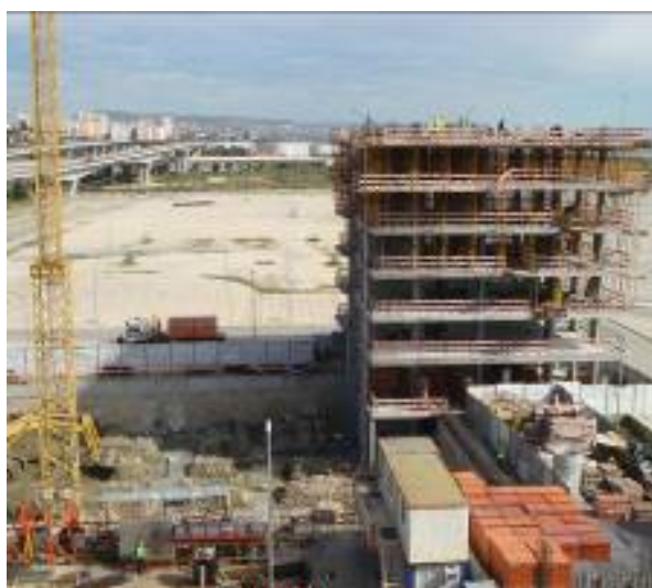
Figura 3 – Vista da construção de um dos edifícios
