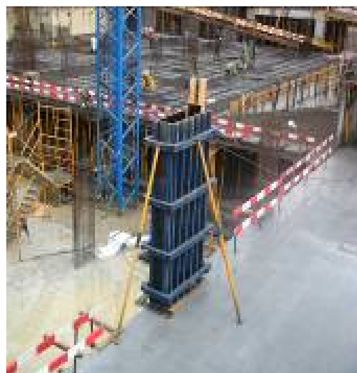
Figura 2 – Pormenor da construção corrente de pilares de bordadura
