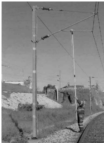
Figura 2 – Colocação de Varas de Terra
