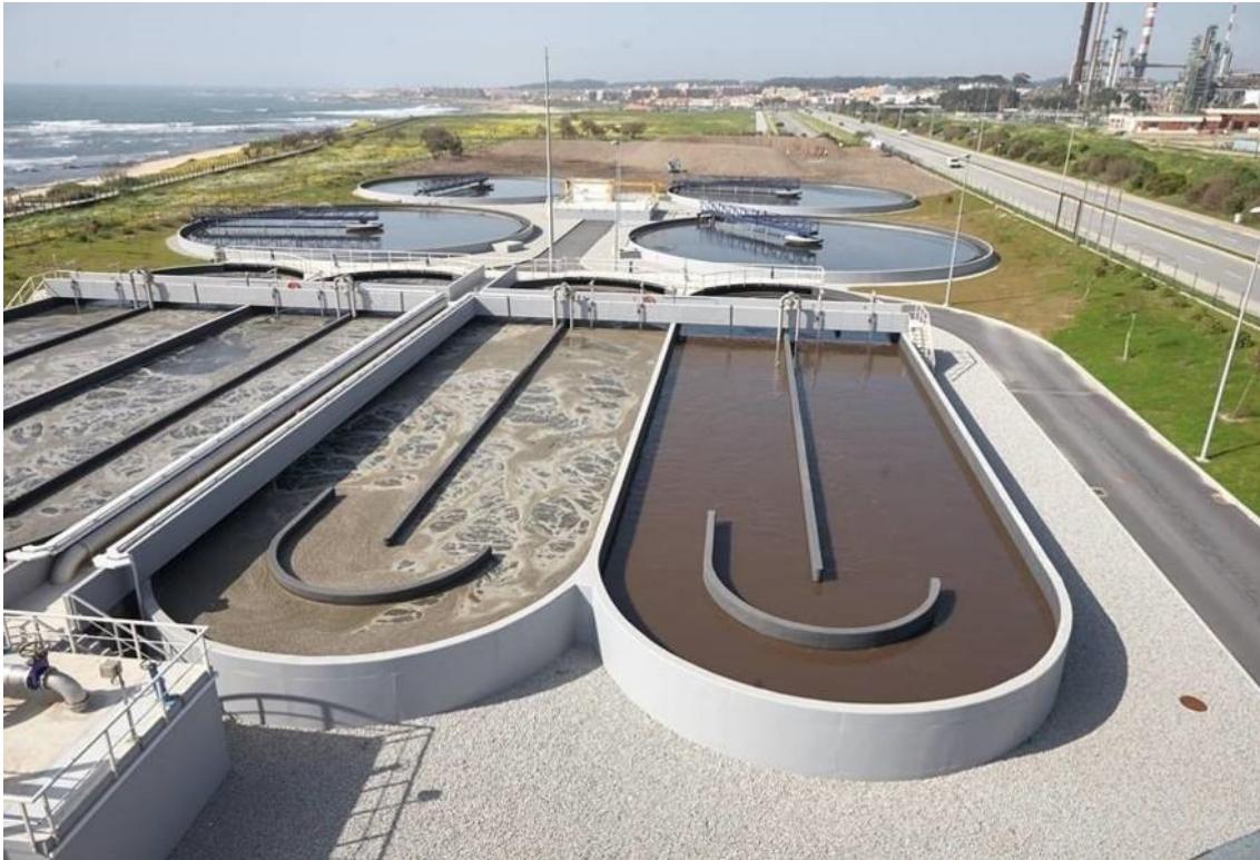
Figura 48 – Tanques de arejamento e decantadores secundários da ETAR de Matosinhos (Fonte: www.cm-matosinhos.pt ).
