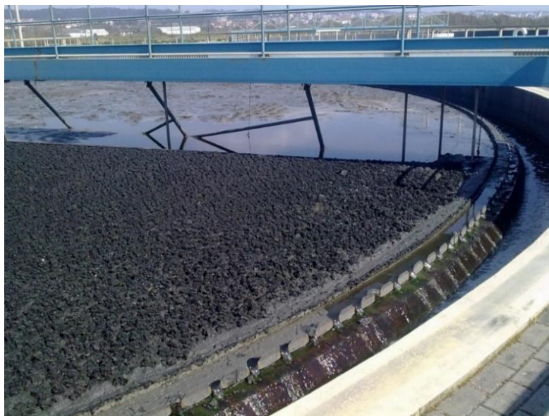
Figura 52 – Flutuação de lamas no decantador secundário da ETAR de Espinho.
