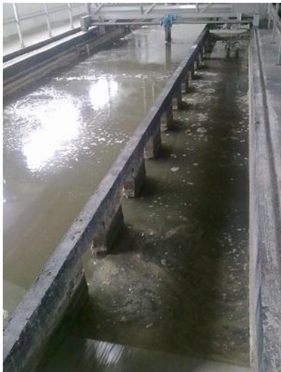
Figura 39 – Desarenador/desengordurador da ETAR do Ave: a) ponte móvel com bomba extratora de areias; b) acumulação de gorduras por ação do ar comprimido injetado na parede oposta.
