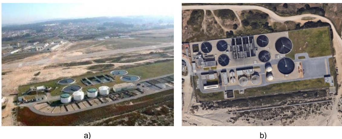
Figura 61 – ETAR de Espinho: a) configuração inicial (1998-2006); b) após obras de remodelação concluídas em 2006 (Fonte: www.simria.pt ; e Google maps).
