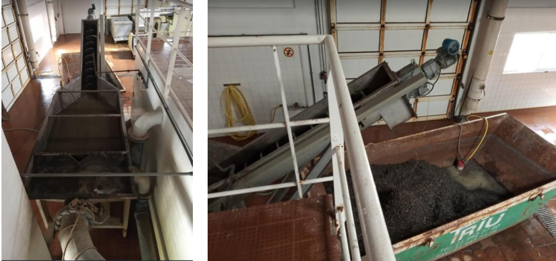
Figura 42 – Classificador de areias da ETAR do Freixo.
