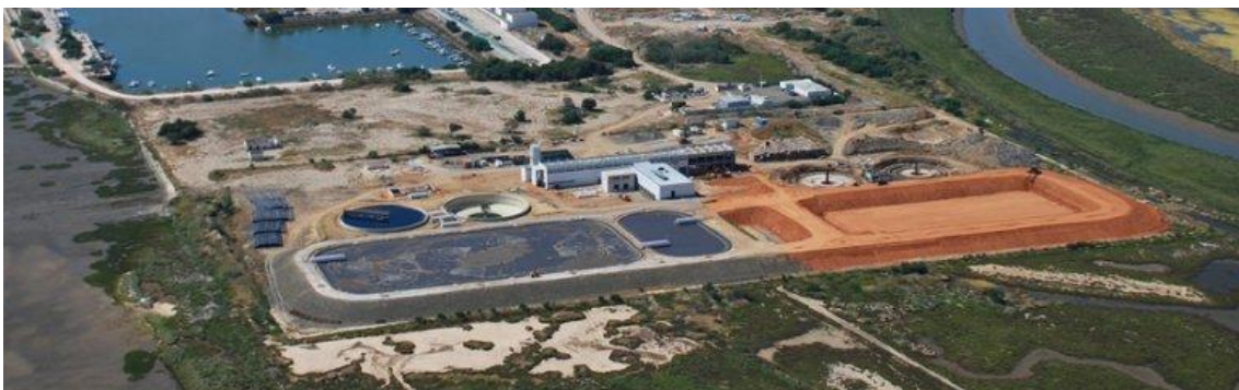
Figura 49 – Lagoas arejadas da ETAR de Vila Real de Santo António (Fonte: www.aguasdoalgarve.pt ).
