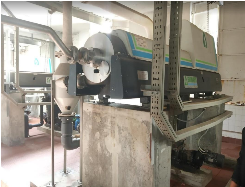
Figura 66 – Linha de centrifugadoras da ETAR do Freixo.
