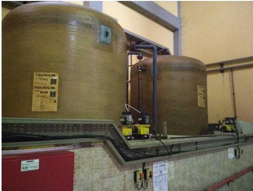
Figura 79 – Biofiltros da ETAR de Gaia Litoral.
