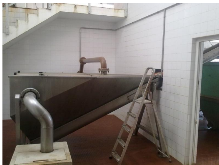
Figura 41 – Classificador de areias da ETAR de Espinho.
