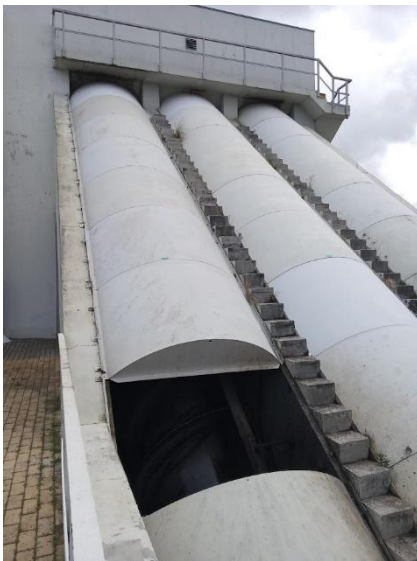
Figura 32 – Parafusos de Arquimedes na ETAR do Ave.
