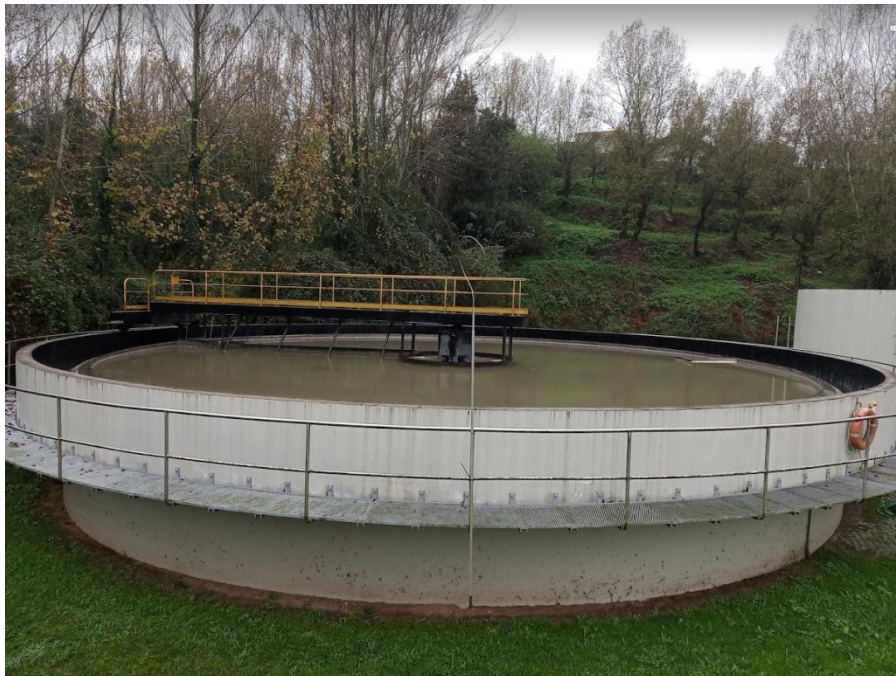
Figura 44 – Decantador primário, circular, da ETAR do Areinho.
