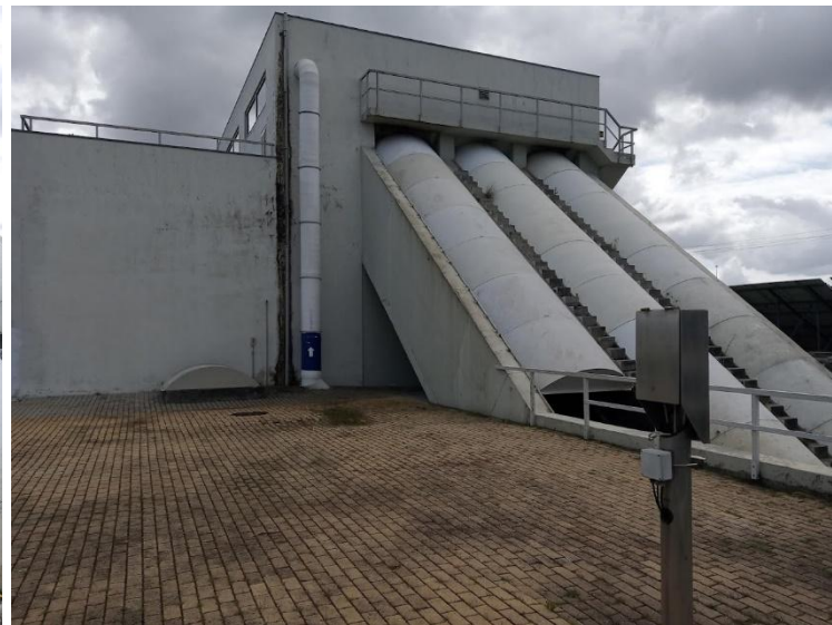
Figura 32 – Parafusos de Arquimedes na ETAR do Ave.
