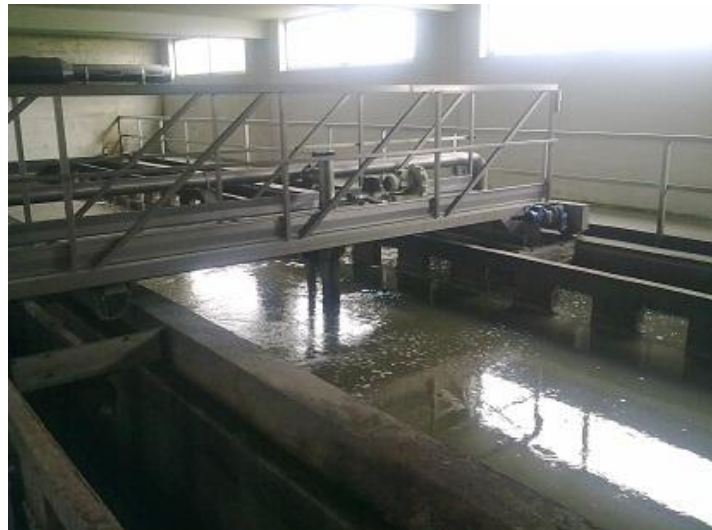
Figura 39 – Desarenador/desengordurador da ETAR do Ave: a) ponte móvel com bomba extratora de areias; b) acumulação de gorduras por ação do ar comprimido injetado na parede oposta.
