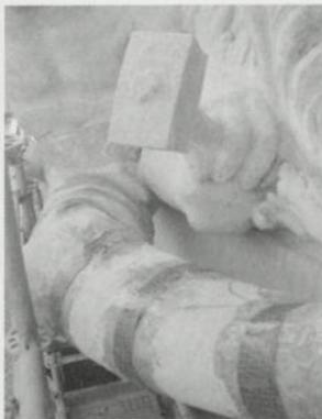
Figura 24: Aplicação das cintas exteriores
