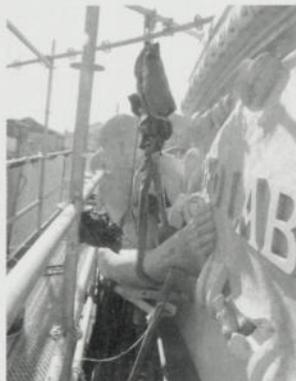
Figura 23: Limpeza e escombramento do membro
