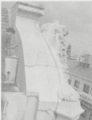
Figura 15 – Parede da fachada onde apoiam as imagens
