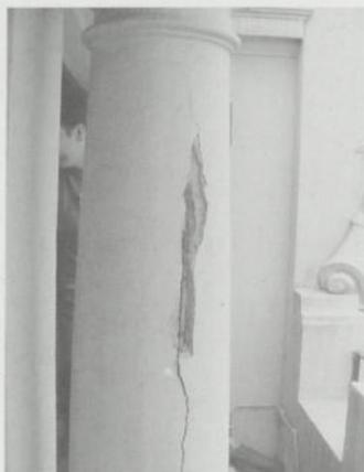
Figura 19 – Fissuração em pilar
