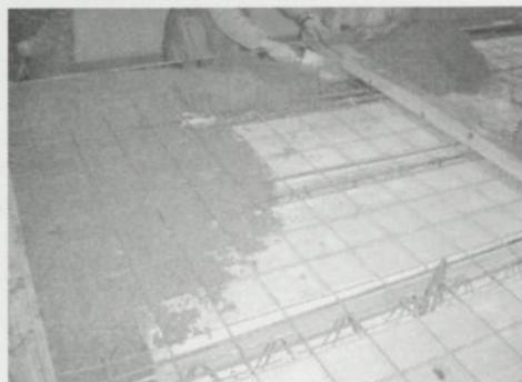
Figura 6 – Fase de betonagem da lâmina de compressão.
