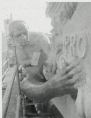
Figura 26: Confinamento contínuo com uma camada de tecido
