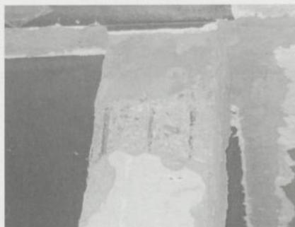
Figura 40: Armadura num pilar
