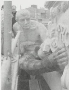
Figura 25: Reforço da fixação e impregnação.
