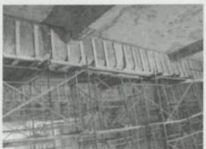
Figura 48: Reforço de viga
