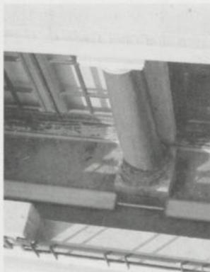
Figura 28: Confinamento do pilar com camada de tecido
