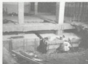
Figura 16: Novas sapatas e do reforço do pilar.
