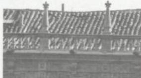
Deformação excessiva ou ruína parcial da estrutura de apoio e seu efeito sobre o telhado.
