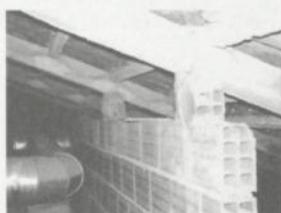
Apoio corrente das varas sobre as paredes de alvenaria e apoio instável sobre tijolo não travado.
