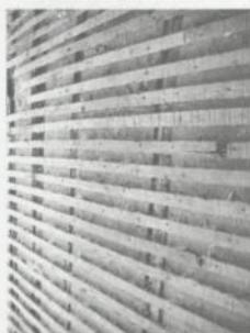
Figura 2: Exemplo de parede interior em taipa de rodízio.
