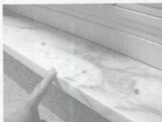
Pedra de espessura muito reduzida ou mal apoiada com elevado risco de fissuração
