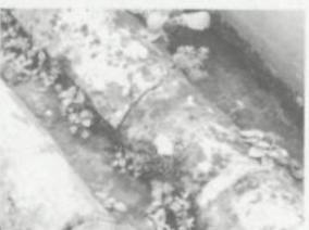
Degradação da telha canudo (capa e caleira) e falta de limpeza e manutenção.
