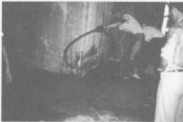
Figura 24: Betonagem da caixa de escadas.
