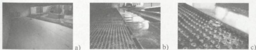
Figura 6: a) Pormenor da placagem de isolamento térmico de poliestireno extrudido; b) e c) Pormenor da colocação tela plástica e das lâminas de cobre.
