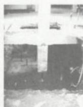
Figura 13: Microestacas a atravessar a fundação existente.
