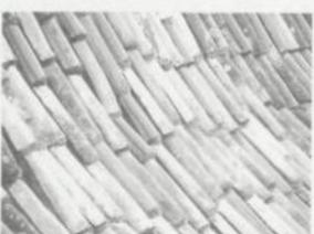
Telhado muito inclinado argamassado e com grampos, submetido a uma reparação local da pior qualidade.
