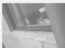
Peitoril sem revestimento específico contínuo e impermeável.
