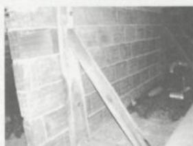
Deslocamento de ripa, com perda do apoio da telha e escoramento de recurso das paredes.
