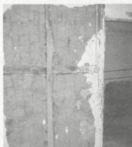
Figura 3: Parede interior com construção tipo *Fachwerk*.
