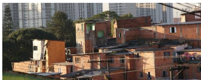
Figura 2: Exemplo de tipologia construtiva encontrada em São Remo. Fonte: Ben Tavene.
