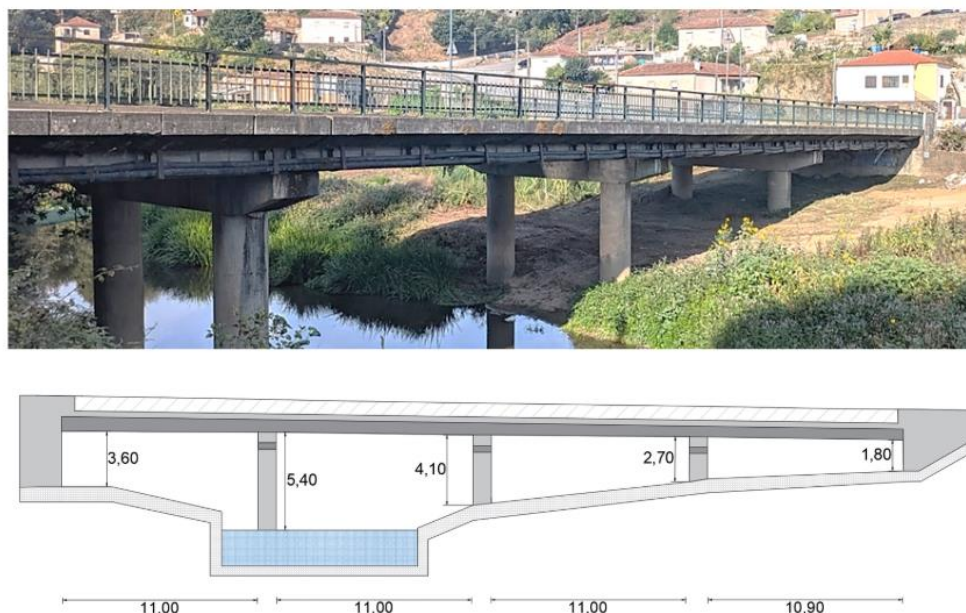
Figura 3: Ponte de Santa Helena: vista geral da estrutura (superior) e esquema simplificado da geometria longitudinal (inferior) [12].
