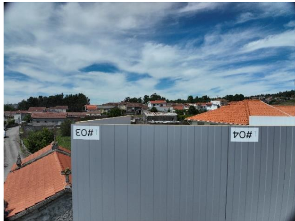
Figura 4: Painéis sandwich montados no demonstrador com identificação numérica visível [1]
