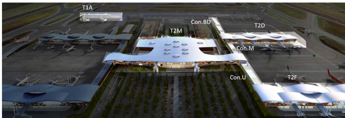
Figura 1 - Vista geral do Terminal 2 com identificação dos edifícios e delimitação da fase de intervenção analisada.
