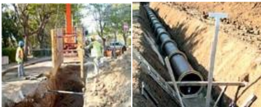
Figura 3. Reabilitação de condutas com abertura de vala.
